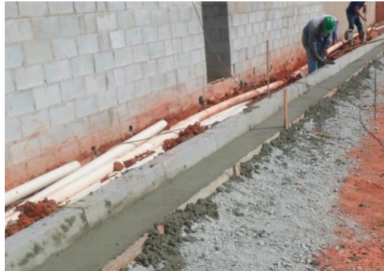
FIGURA 4: Exemplo de execução de sarjeta moldada in-loco
