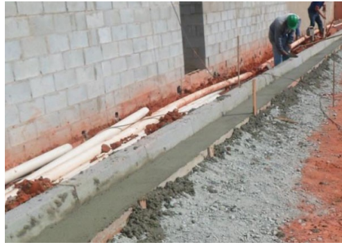
FIGURA 3: Exemplo de execução de sarjeta moldada in-loco
